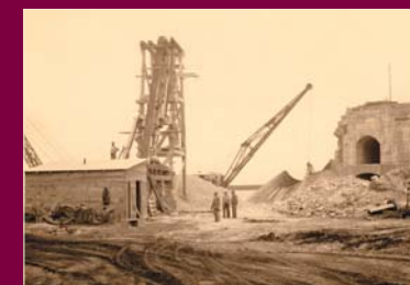
Crushing limestone for the bridge. Concassage de la pierre calcaire pour le pont.
